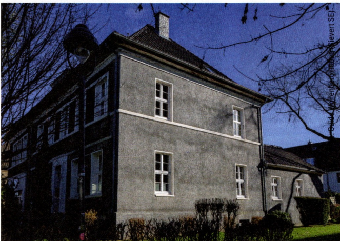
Abb. 7: Ein leichter Standortwechsel zeigt, wie unterschiedlich der Kellenwurfputz in Erscheinung treten kann.
