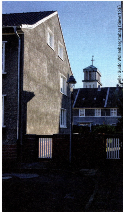
Abb. 6: Je nach Lichteinfall treten Strukturen und Schattierungen im Putz unterschiedlich stark hervor.
