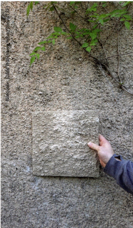
Abb. 5: Mithilfe von Putzmustern wird die Rezeptur des neuen Putzes optimal eingestellt.
