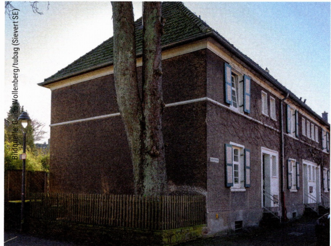
Abb. 9: Der historische Bereich der Margarethenhöhe umfasst 1.300 Wohnungen. Hier wird es auch in Zukunft viel zu tun geben.
