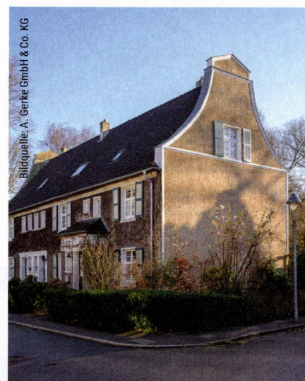
Abb. 4: Die Sanierungsmaßnahmen erfolgen nach Bedarf. Es ist keine Seltenheit, dass nur eine Gebäudeseite erneuert wird.
