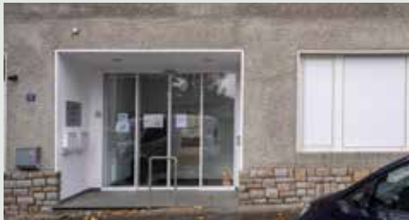
Der Geldautomaten-Standort im Ärztehaus ist bereits barrierefrei umgebaut.
