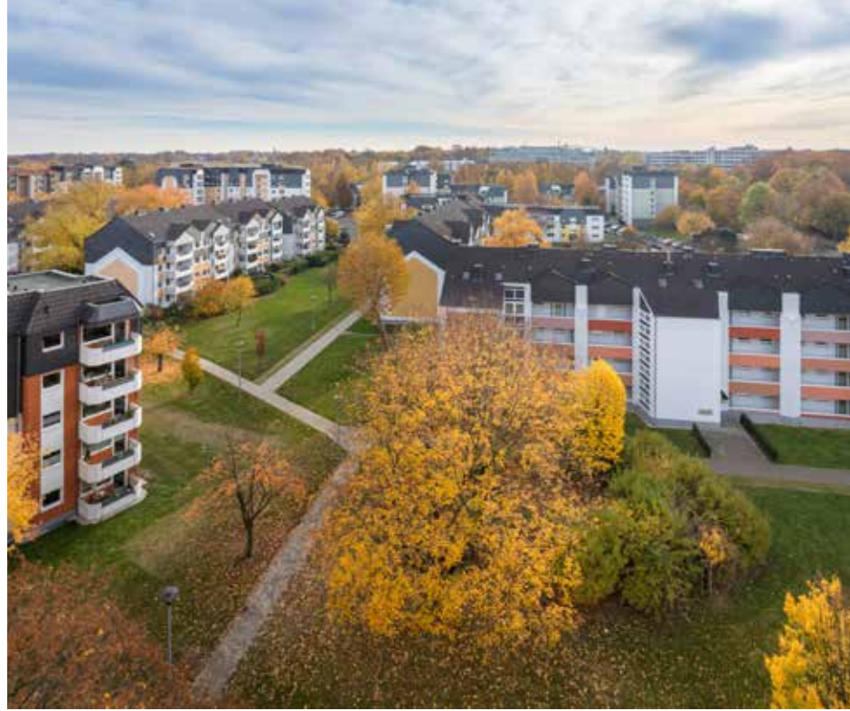
Die Fotos (von Seite 10 ausgehend im Uhrzeigersinn), Blick aus der Metzendorfstraße 5, der Borkumstraße 30, auf die "Neue" Höhe und aus Zur Eibe 6.
