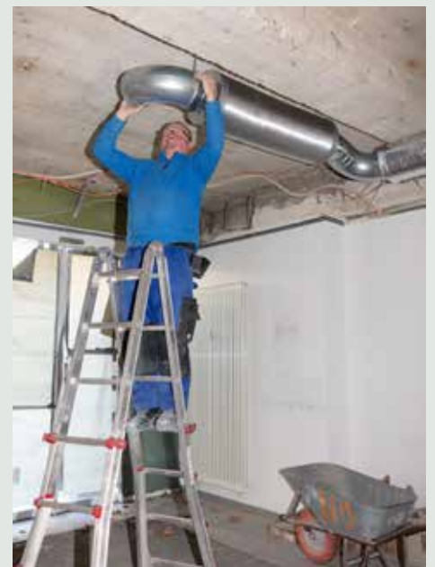
Konzentriertes Arbeiten in der Höhe: Norbert Bruns richtet die Belüftung ein.
