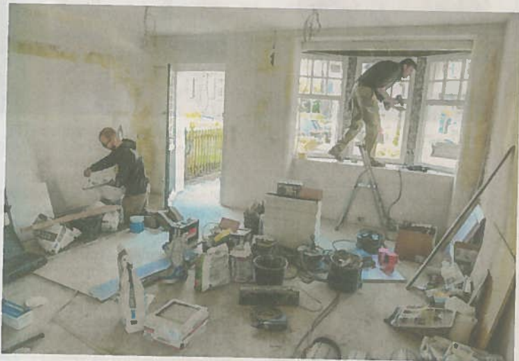
Derzeit laufen die Renovierungsarbeiten in den Räumen des ehemaligen Kloiddladens am Laubenweg 11.
