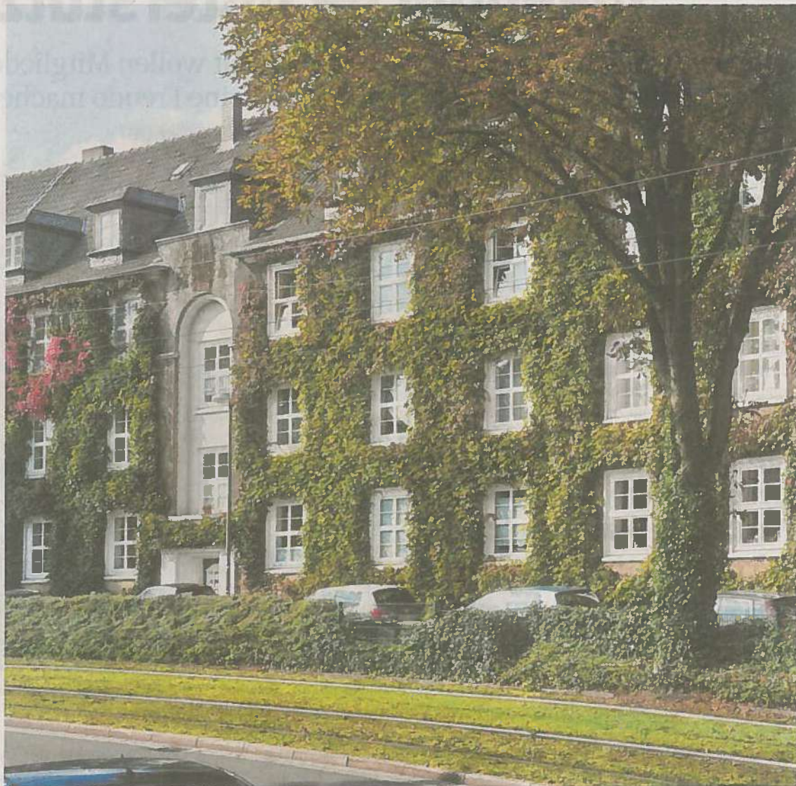
In ausgewählten Wohnungen und Häusern auf der alten Margarethenhöhe liefern Module Daten über den Strom- und Heizungsverbrauch der Bewohner. Diese werden im Rahmen des Forschungsprojektes ausgewertet. FOTO: ULRICH VON BORN
