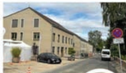
Drei neue Wohnhäuser mit 42 Wohnungen sind jetzt am Lehngrund entstanden.
