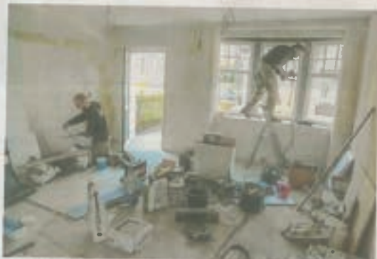
Derzeit laufen die Renovierungsarbeiten in den Räumen des ehemaligen Kloiidtadens am Laubenweg 11.
