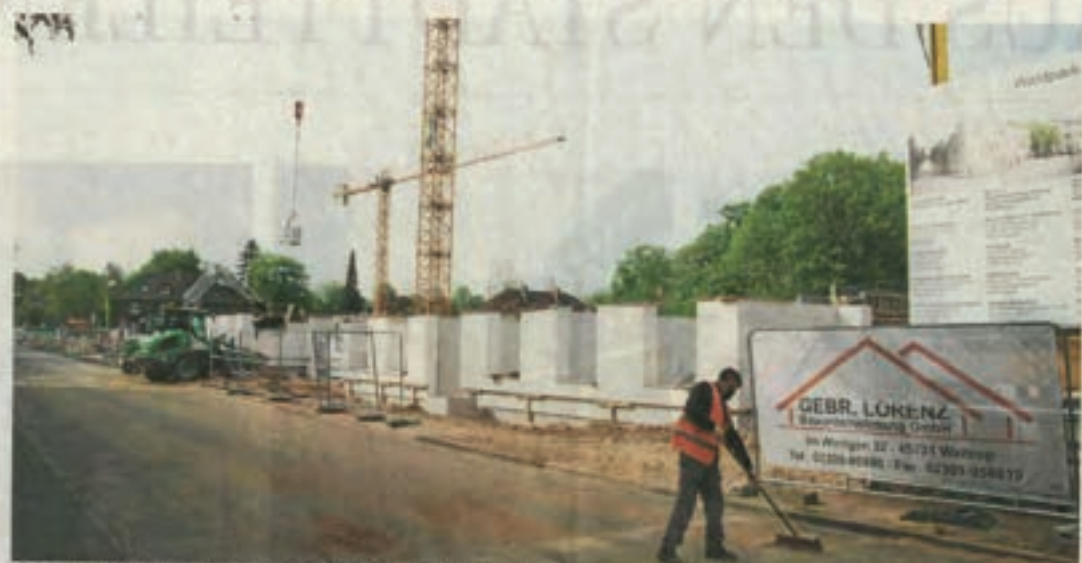
Die neuen Wohnhäuser am Lehngrund auf der Margarethenhöhe nehmen Form an. Einzug soll im Herbst 2023 ein. DAK & FREDRICKS/PT
