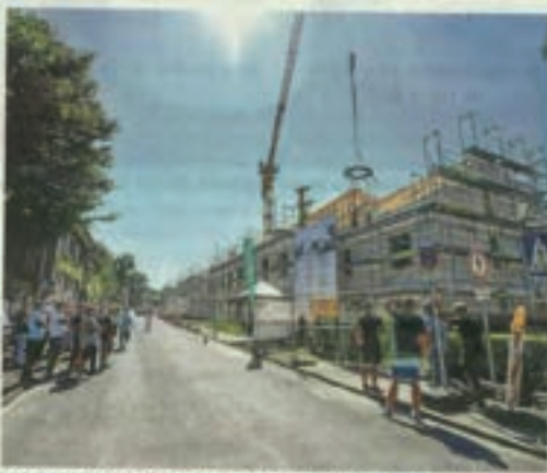
Nachbarn und zukünftige Mieter sahen sich den Baufortschritt beim Richtfest an.
