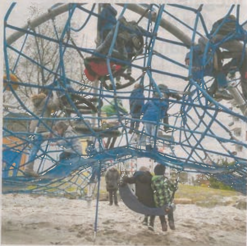
Der Untergrund wurde zunächst aufgearbeitet, dann konnte das Spielgerät auf dem Areal an der Borkumstraße mit seinen Seilen, Brücken und Rutschelementen fast installiert werden.
