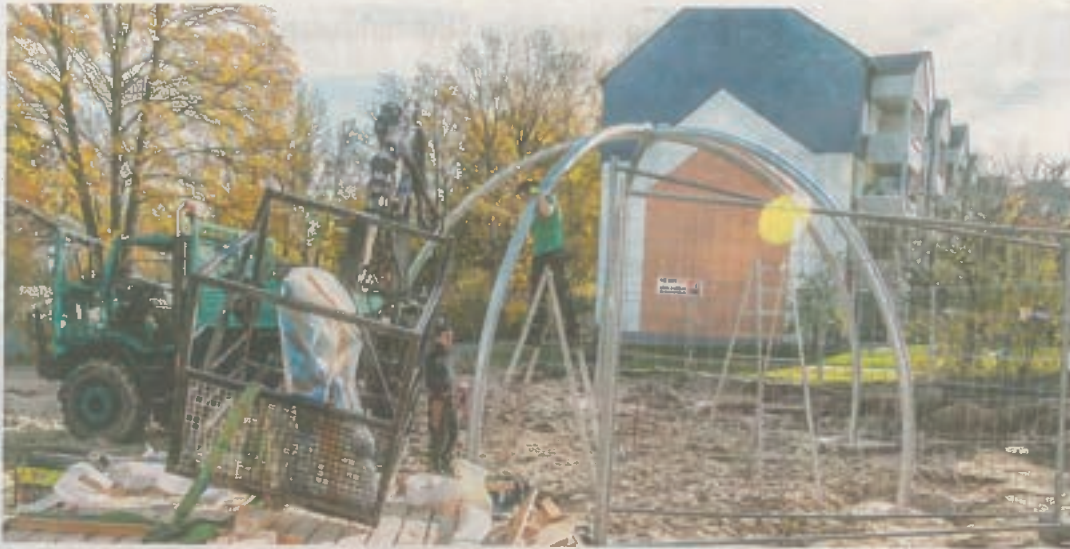
Arbeiter stellen das neue Spielgerät – den Favoriten der Kinder – auf der neuen Margarethenhöhe an der Ecke Helgolandring/Borkumstraße auf. FOTOS: LENA MÖLDER
