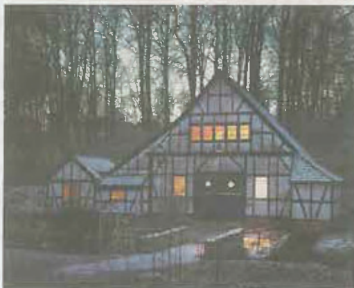
Der Halbachhammer stand einst in Weidenau an der Sieg. Gustav Krupp von Bohlen und Halbach ließ ihn demontieren und im Nachtigallental aufbauen.
