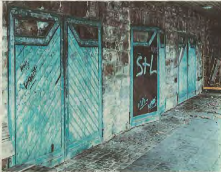
Bei den Fotoprofis belegte Volker Sander den ersten Platz. Er reichte unter anderem dieses Bild von den Lager- und Toilettenräumen am Marktplatz der Margarethenhöhe ein. FOTO: VÖLKER SANDER
