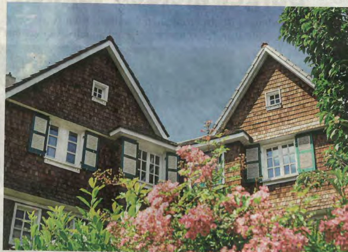
Die denkmalgeschützten Häuser auf der alten Margarethenhöhe unter energetischen Gesichtspunkten zu sanieren, ist eine Herausforderung, da die Denkmalschutzauflagen beachtet werden müssen. FOTO: JULIA TILLMANN / FFS
