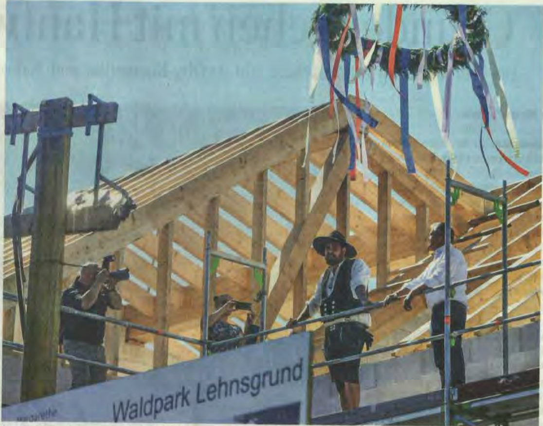
Richtfest am Lehngrund auf der Margarethenhöhe: Michael Flachmann (r.), Vorstand der Margarethe-Krupp-Stiftung, und ein Zimmermann beim Richtspruch auf dem Dach.
