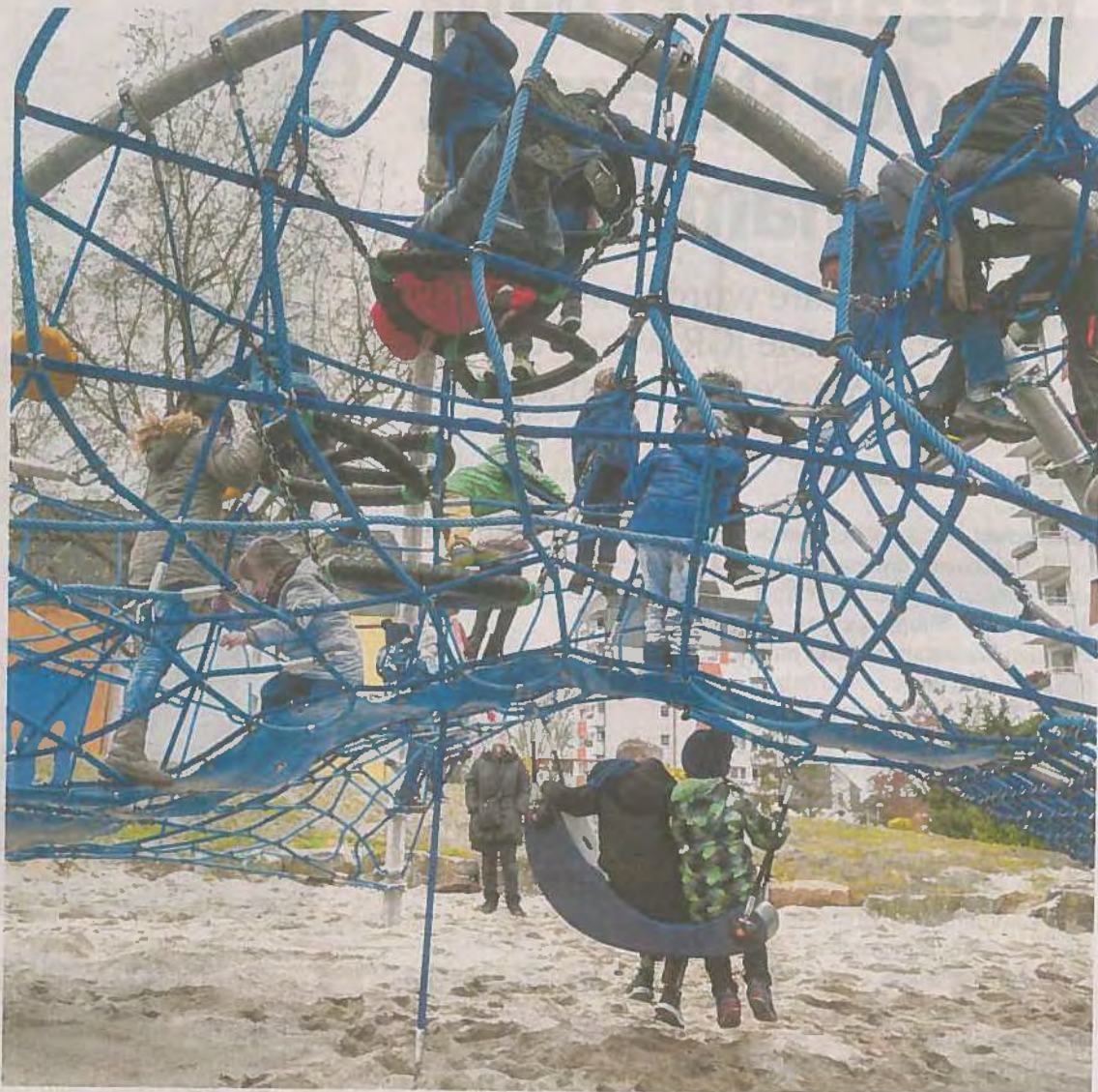
Der Untergrund wurde zunächst aufgearbeitet, dann konnte das Spielgerät auf dem Areal an der Borkumstraße mit seinen Seilen, Brücken und Rutschelementen fest installiert werden.
